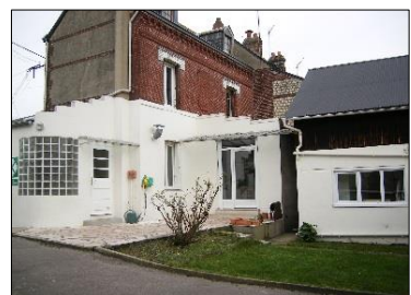
Atelier de jour « Les Lauriers » à Sotteville-les-Rouen
