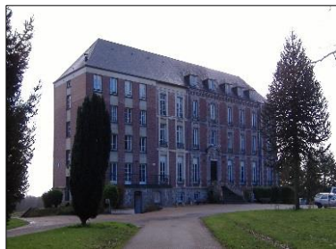
Atelier de jour et foyer d'hébergement « Les Pommiers » à Mont Cauvaire
